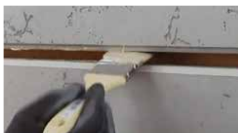
Exemple d'utilisation de la colle FO144 avec le cordon coupe-feu FJ204 et le silicone FS703.
